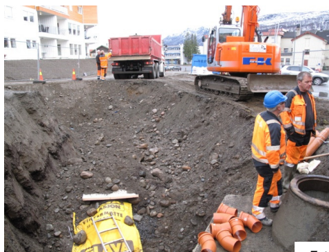
Vann og avløpsledning er skiftet i Nedre del av Gammelveien
