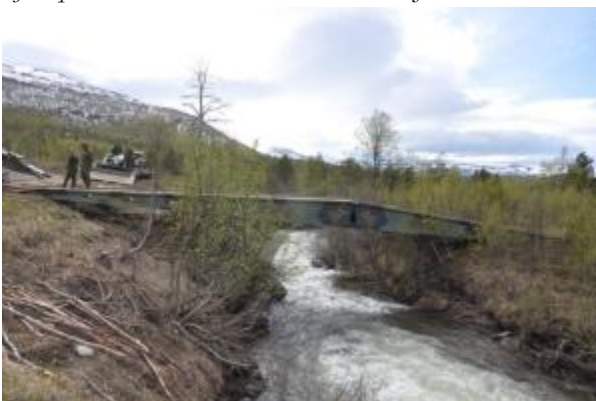
Kobbryggelva, utlegging av midlertidig bru
