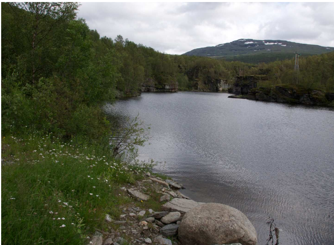
Figur 4 «Fosshøla» sett oppover fra vannverket.
