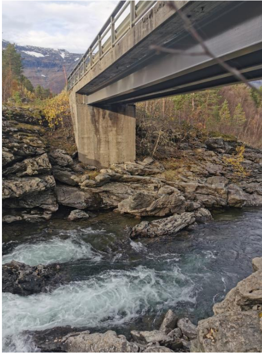
Figur 1-8 Sett fra oppstrøms side
