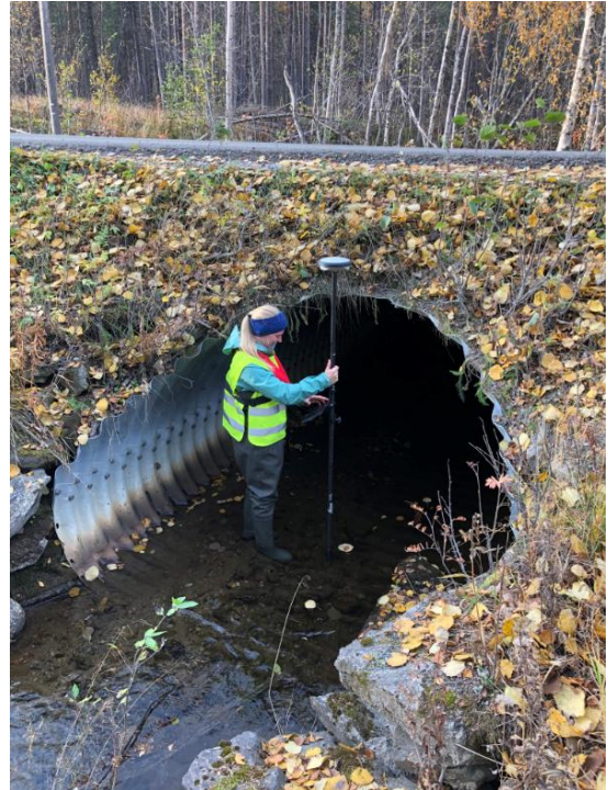
Figur 1-3 Innmåling på oppstrøms side
