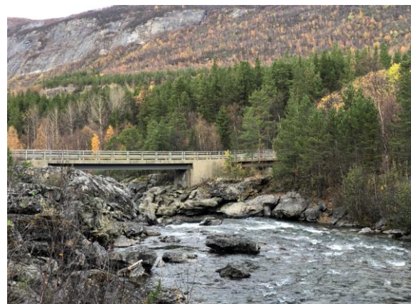
Figur 1-11 Sett fra oppstrøms side
