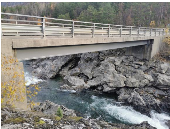
Figur 1-10 Sett fra oppstrøms side
