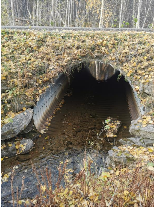
Figur 1-2 Sett fra oppstrøms side
