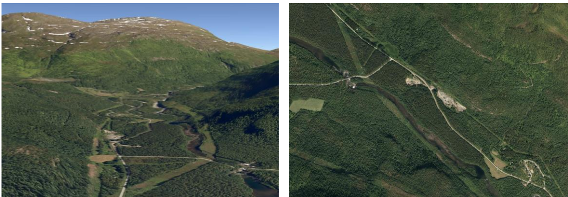
Figur 1-3: Venstre: 3D-illustrasjon dagens situasjon i området, retning øst (Multiconsult 3D-app). Høyre: flyfoto av dagens situasjon (finn.no).
