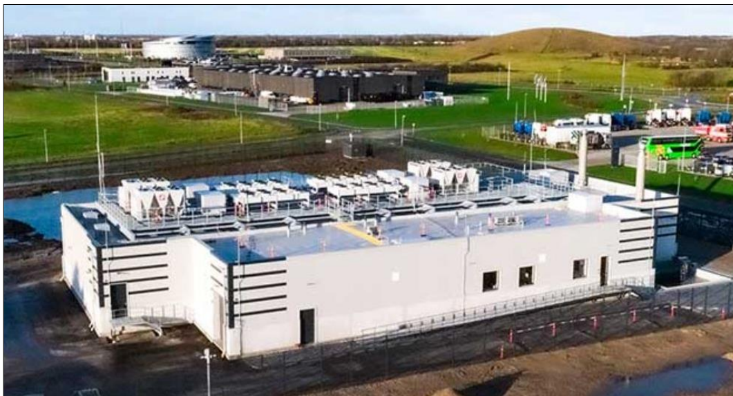
Figur 3. Eksempel på datasenter med ventilasjons- og kjølevifter på taket; Esbjerg Campus data center i Danmark.
